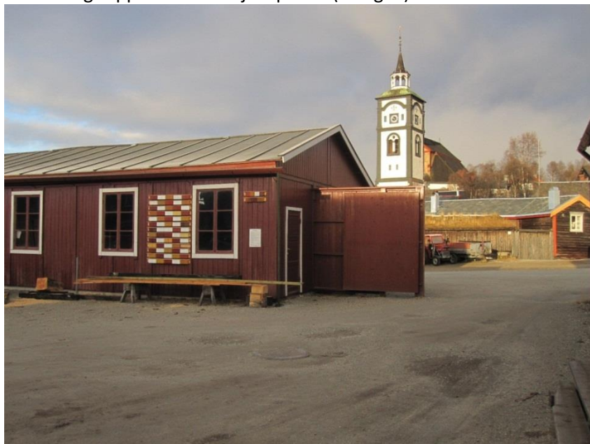
Figur 6. Malingprøvene montert på sydveggen på «Raugarasjen». Foto. Brønne, 2012.
